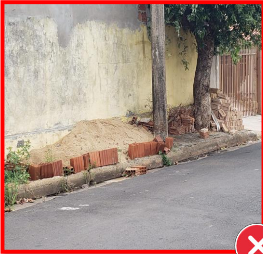
Material de construção impedindo a passagem
