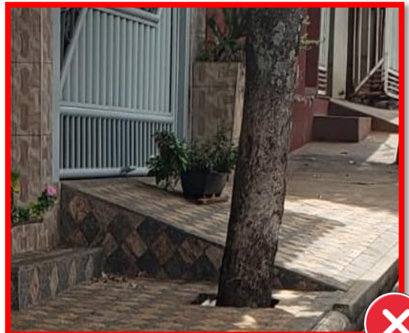
Degrau na calçada e rampa acentuada
