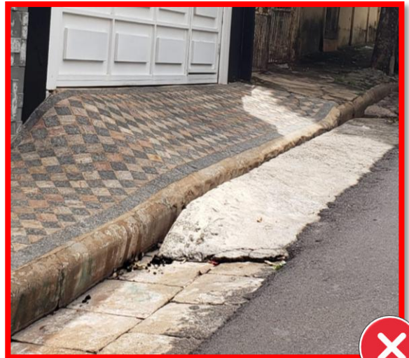
Rampas em via pública
